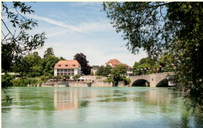
Haus Salmegg und die Rheinbrücke bei Rheinfelden
